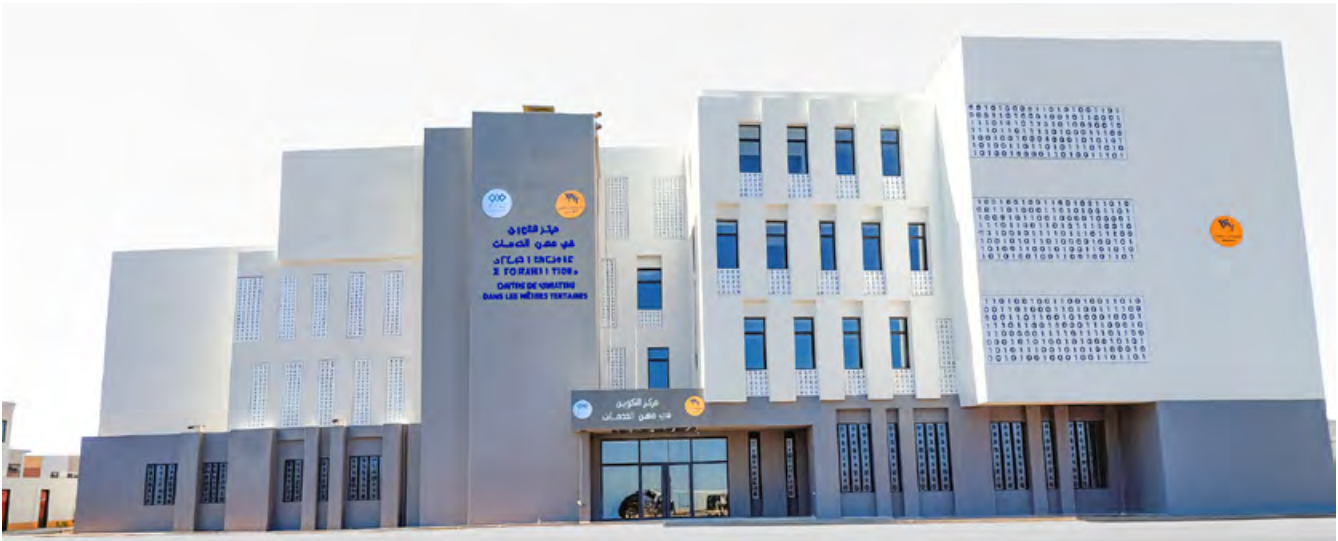
CENTRE DE FORMATION DANS LES MÉTIERS TERTIAIRES DE L'OASIS - CASABLANCA
